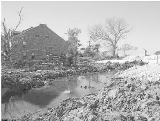
写真-2 ニューオーリンズ市内の破堤箇所周辺 (国総研撮影)
