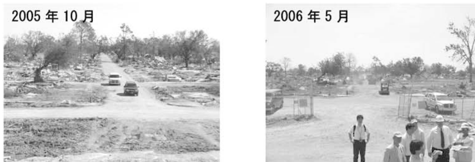
写真-5 ニューオリンズ Inner Harbor Navigation Channel 破堤箇所背後の情況
