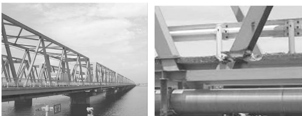
写真－２ 斜材が破断した木曾川大橋
