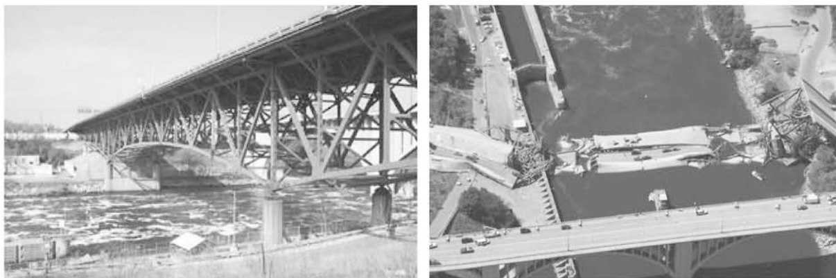
写真－１ 崩壊したミネアポリスのトラス橋
