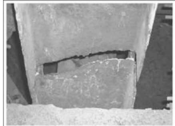
斜材の破断(1箇所)
