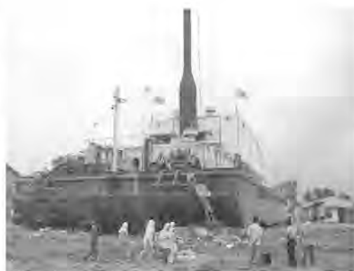
写真-1 係留場所から 3km 移動したパワープラント（インドネシア、港湾空港技術研究所提供）
