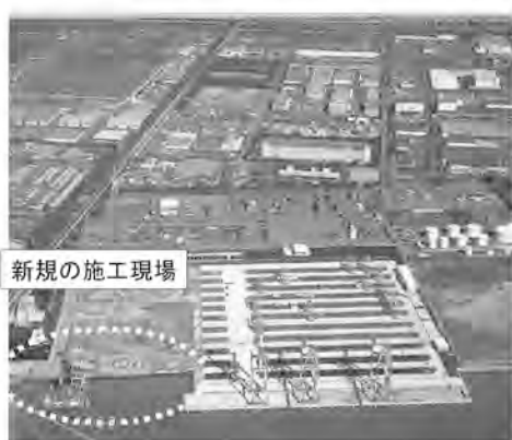
図-6.1 名古屋港飛島地区
