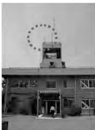
千葉港基地局の受信アンテナ
