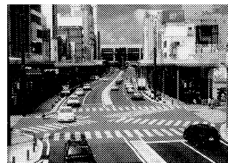
写真-1 整備後の状況
