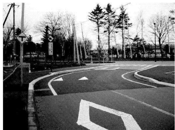
写真-1 整備後の交差点 (T字交差)
