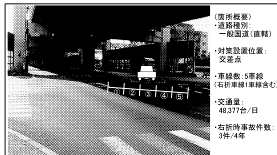
写真-2 国道に設置した右折導流標示
