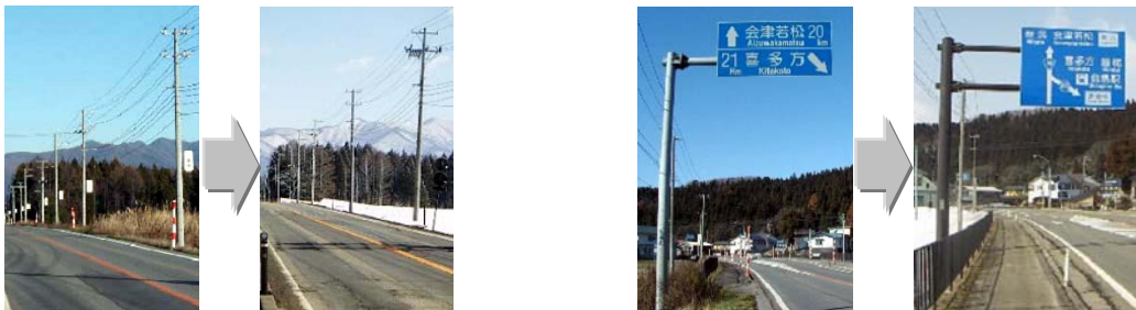
写真Ⅱ.5：電柱袖巻広告撤去の例と標識支柱の色彩配慮の例
