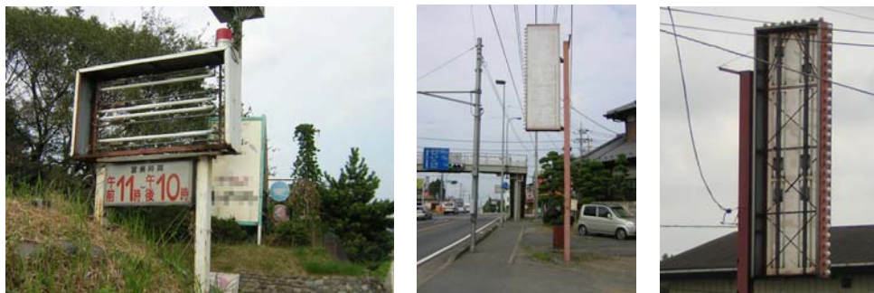
写真Ⅱ.6：破損したまま放置された屋外広告物
