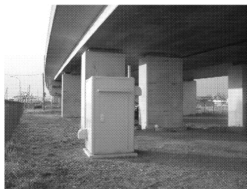
写真-1 強震観測施設の例 (国道 8 号小白石高架橋)
