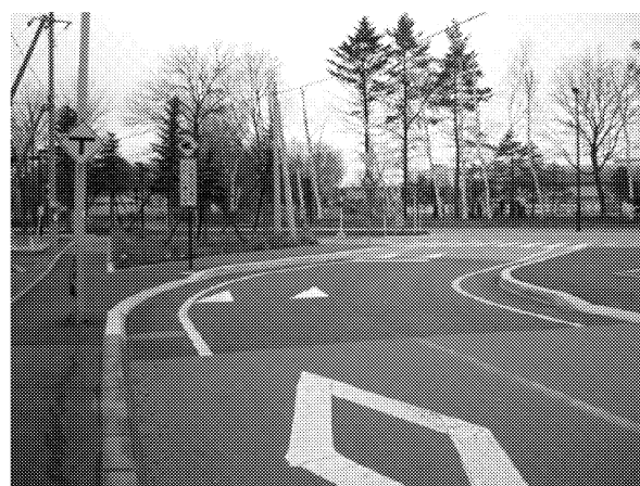
写真-1 整備後の交差点（T字交差）
