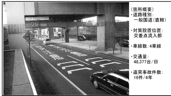
写真-1 国道に設置した減速路面標示
