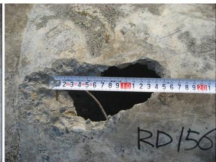
写真3 D-3 引き上げの際に穴
