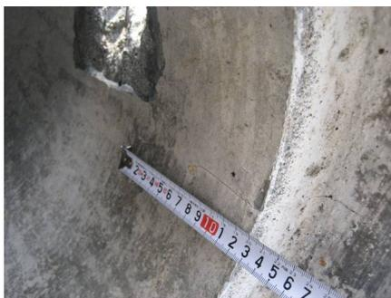
写真1 D-3「破損」Cランク
