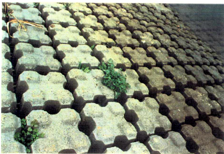
写真－動物 9－2 ブロックマット施工後の状況
