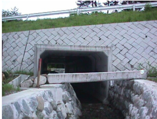
写真－事例 17－5 動物の通路（内部左側）を確保したボックスカルバート
