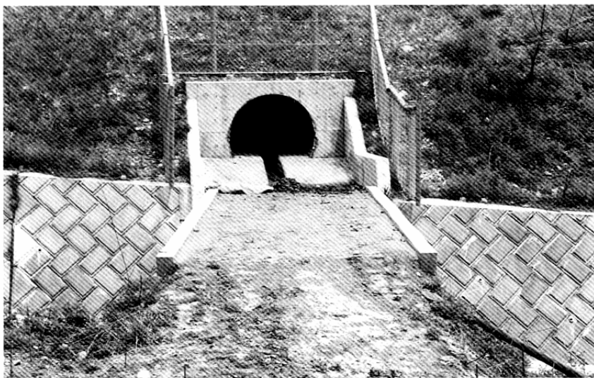
図 I -21 パイプカルバート設置時の留意事項
