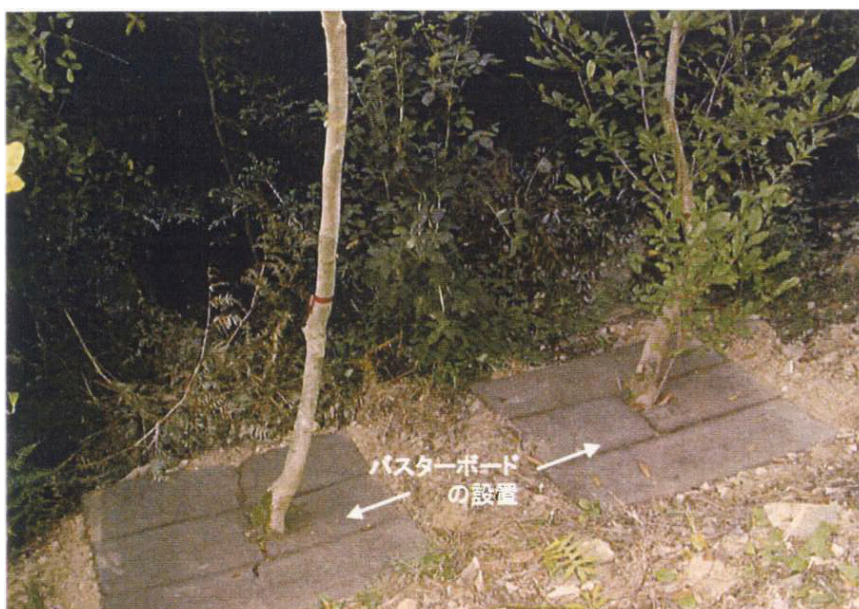
写真一植物 6ー2 一般国道 475 号（東海環状自動車道） バスターボード敷設状況
