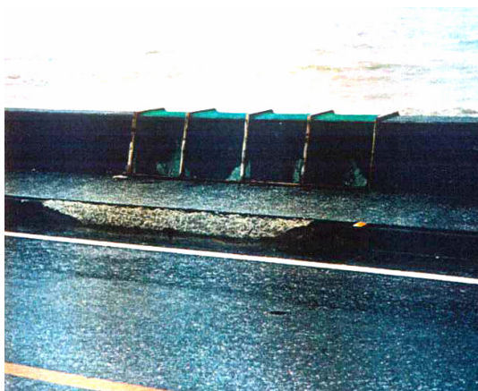
車道に出た小動物が速やかに道路外へ脱出できるように歩道縁石にスロープを付けた。護岸にはネットを設置し乗り越えるための足がかりとした。
