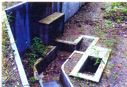
写真—事例 2—2 横断排水ボックスの設置状況（左：入り口、右：内部）
