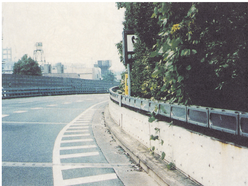
写真一事例 1-1 首都高速道路 2 号線の高欄照明
