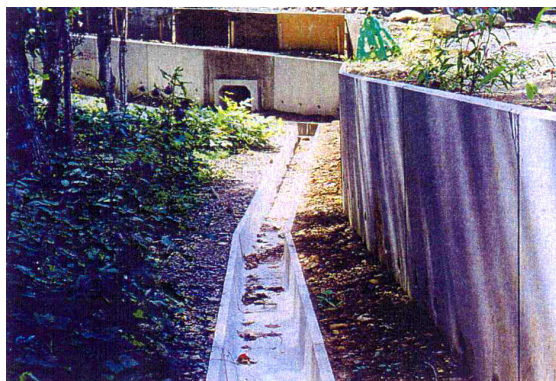
写真－事例 2－4 誘導のための措置（左：プレキャストL型擁壁、右：補強土壁）
