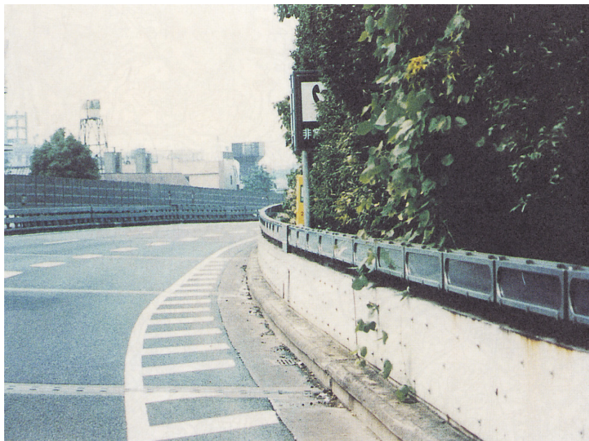
高欄照明の設置事例(事例 No. 1)
