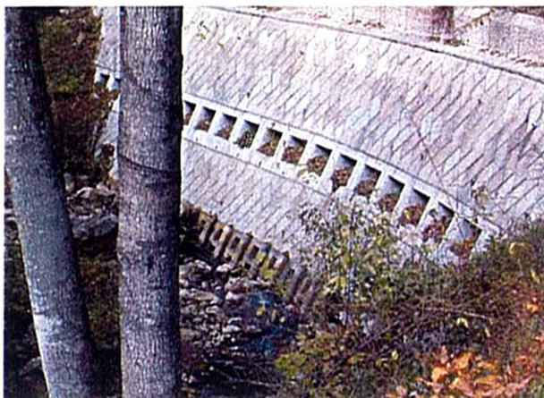
写真－動物 12－1 東海環状（土岐～美濃加茂）：設置されたホタルブロック
