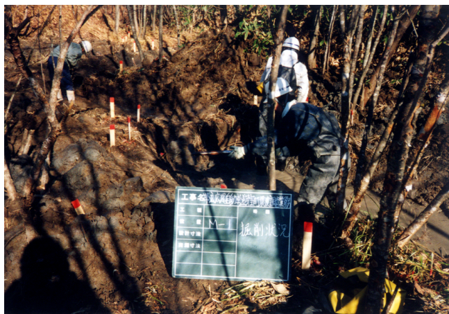
写真－動物 3－3 M1 池造成施工中の状況
