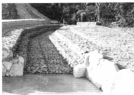
上流からの土砂の流入を防ぐ ふとん籠の動水路
