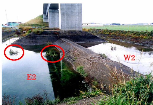
写真 2—3—3 E2・W2 池
