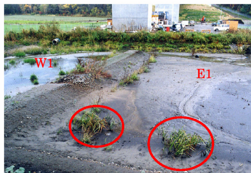
写真 2—3—2 E1・W1 池
