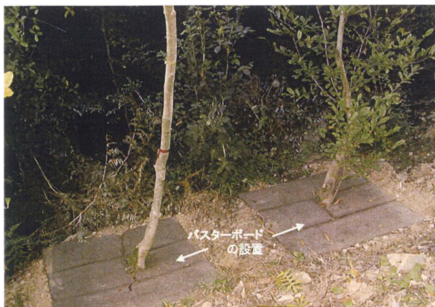
写真－植物 6－2 一般国道 475 号（東海環状自動車道） バスターボード敷設状況
