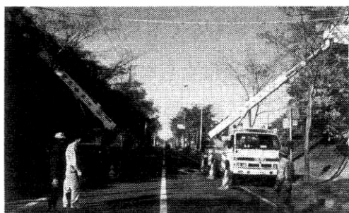
写真一事例 19-1 設置作業風景
