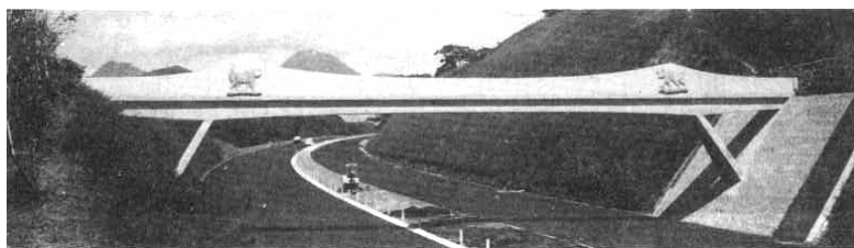
写真-事例 26-1 ニホンザル専用のオーバーブリッジ
