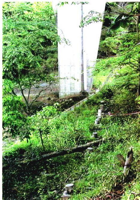
写真－事例 22－2 橋梁下の状況
