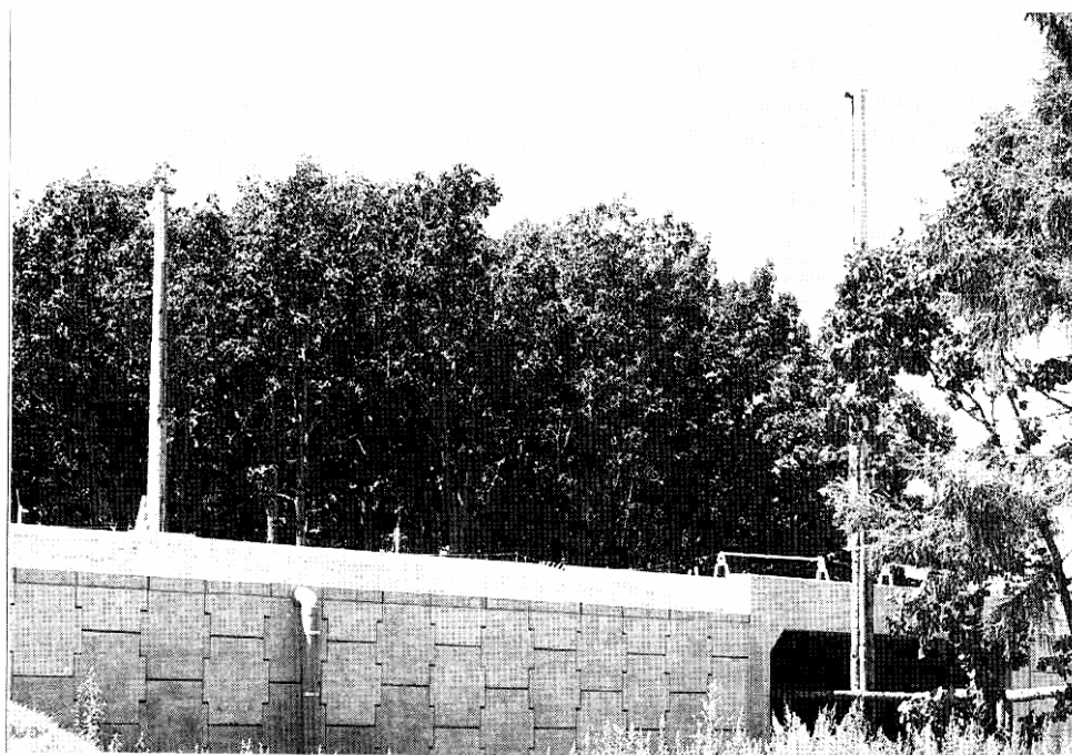
写真－事例 10－2 設置状況
