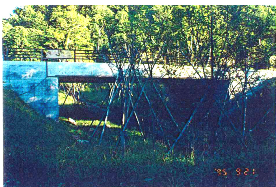
写真-事例 9-2 橋梁下の整備状況
