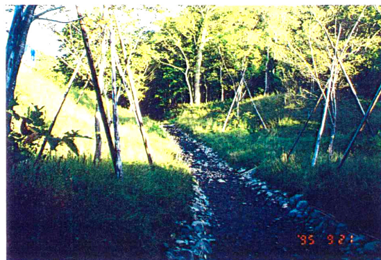
写真-事例 9-3 旧道からのスロープ
