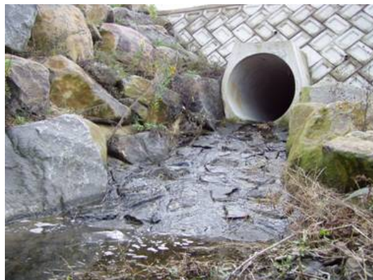
写真一事例 6-2 横断路下流側(調整池側)
