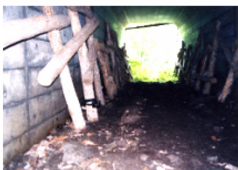
センサーカメラ設置状況
