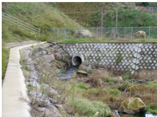
写真一事例 6-1 横断路下流側(調整池側)
