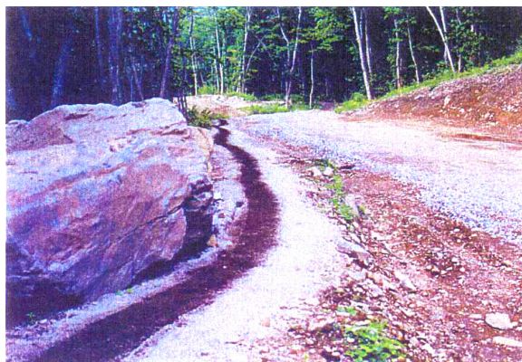
写真一事例 2-6 まき砂（路肩付近に帯状に散布）
