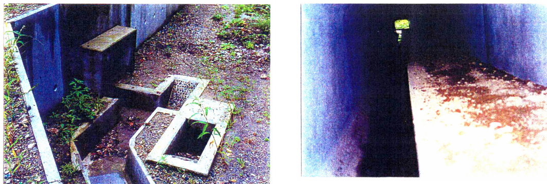
写真一事例 2-2 横断排水ボックスの設置状況 (左: 入り口、右: 内部)
