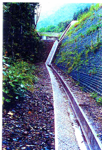
写真－事例 2－4 誘導のための措置（左：プレキャストL型擁壁、右：補強土壁）
