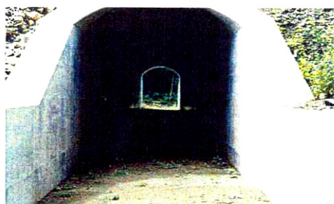
写真一事例 2-1 人道ボックス
