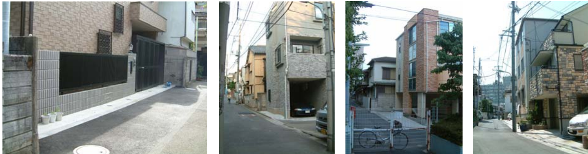
写真 5-1 街並み誘導型地区計画の認定を受けて建替わった建物
