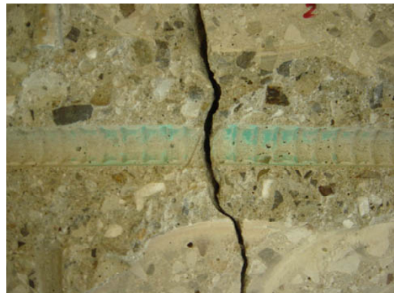
写真 2.5.1(b) 解体後の塗膜の付着状況の例
