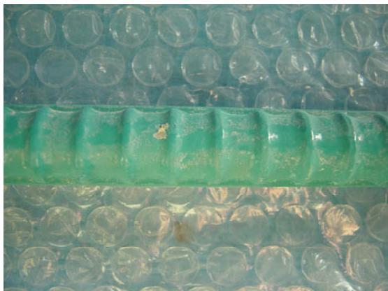
写真 2.5.2 解体後の塗膜の損傷の例
