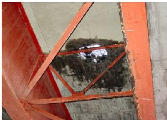
写真 2.1.1 実橋で RC 床版のコンクリート塊が抜け落ちた事例
