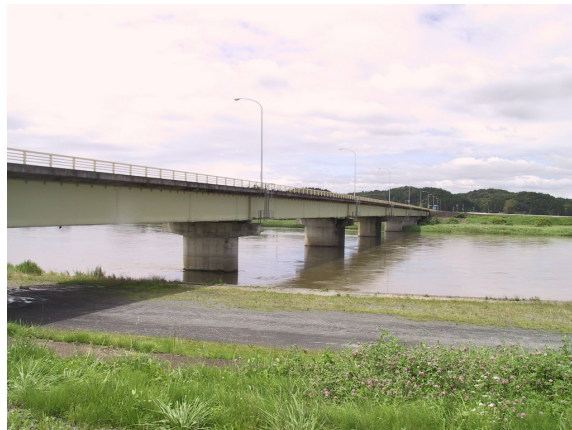
写真 2-4 国道 45 号鳴瀬大橋 (鳴瀬町)
