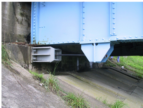
写真 2-3 小野橋の落橋防止構造
