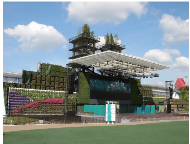
写真-1 バイオラング全景 (バイオラングの手前は、愛・地球広場)
