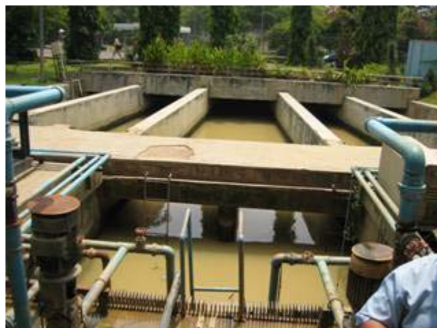
図3-4-3 上水施設（ポンプ場）の様子
