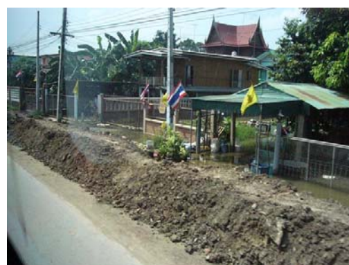
アユタヤ市内の道路沿いの洪水防御用の築堤
