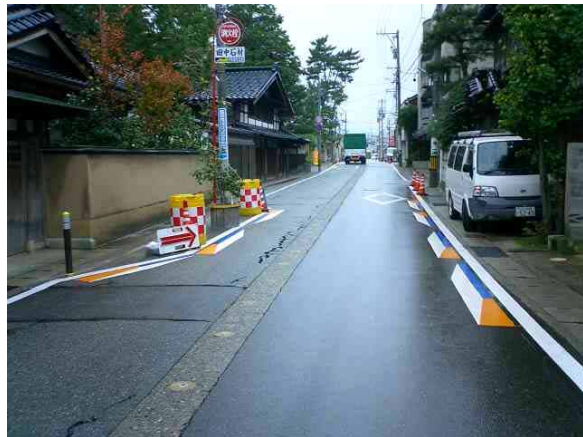
写真-3.1 双方向通行道路における狭さくの設置
