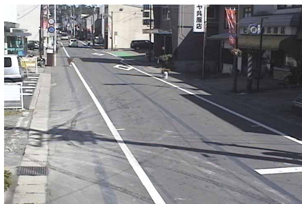
写真-3.2 社会実験時（車道外側線移設時）の状況（道路中央側への外側線移設と、中央線の消去）
