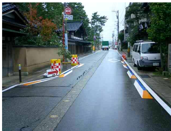
写真-3.1 双方向通行道路における狭さくの設置
