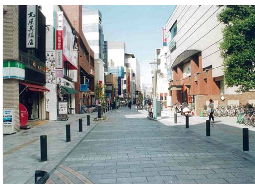
写真-3.3 道路整備後の対象道路
