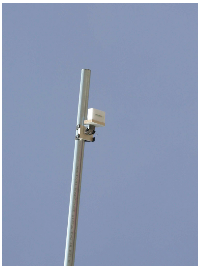
図 6-28 タグ取付け状況
