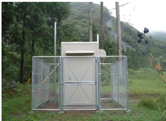
写真-1 強震観測施設の例 (三重県熊野市)
