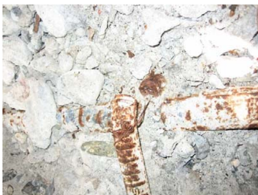
写真1 アルカリ骨材反応による鉄筋破断の例
