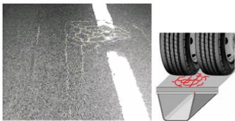
図-6 舗装に生じた変状の様子
