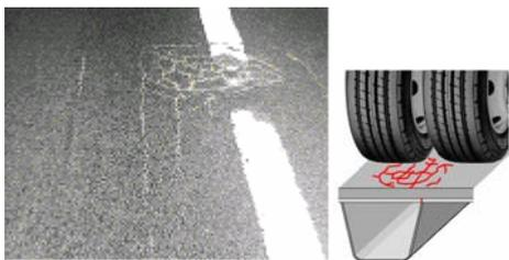
図-6 舗装に生じた変状の様子
