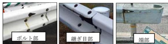
写真-1 防護柵に付着した金属片
