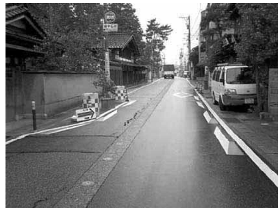
写真-2 双方方向通行道路における狭さくの設置
