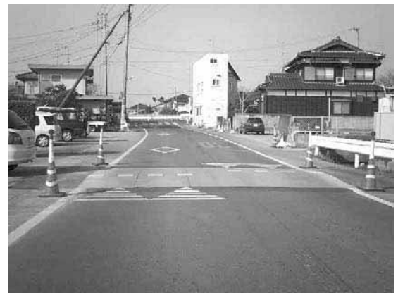
写真-1 ハンプ設置状況
