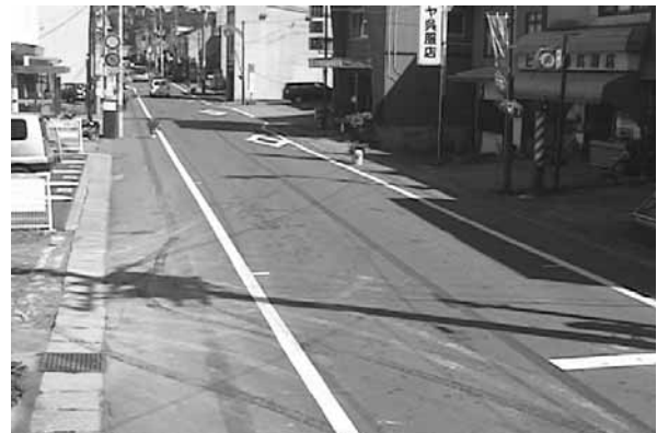
写真-1 社会実験時（車道外側線移設時）の状況 （道路中央側への外側線移設と、中央線の消去）
