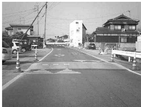
写真-1 ハンプ設置状況
