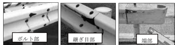
写真-1 防護柵に付着した金属片
