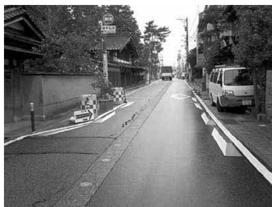
写真-2 双方向通行道路における狭さくの設置
