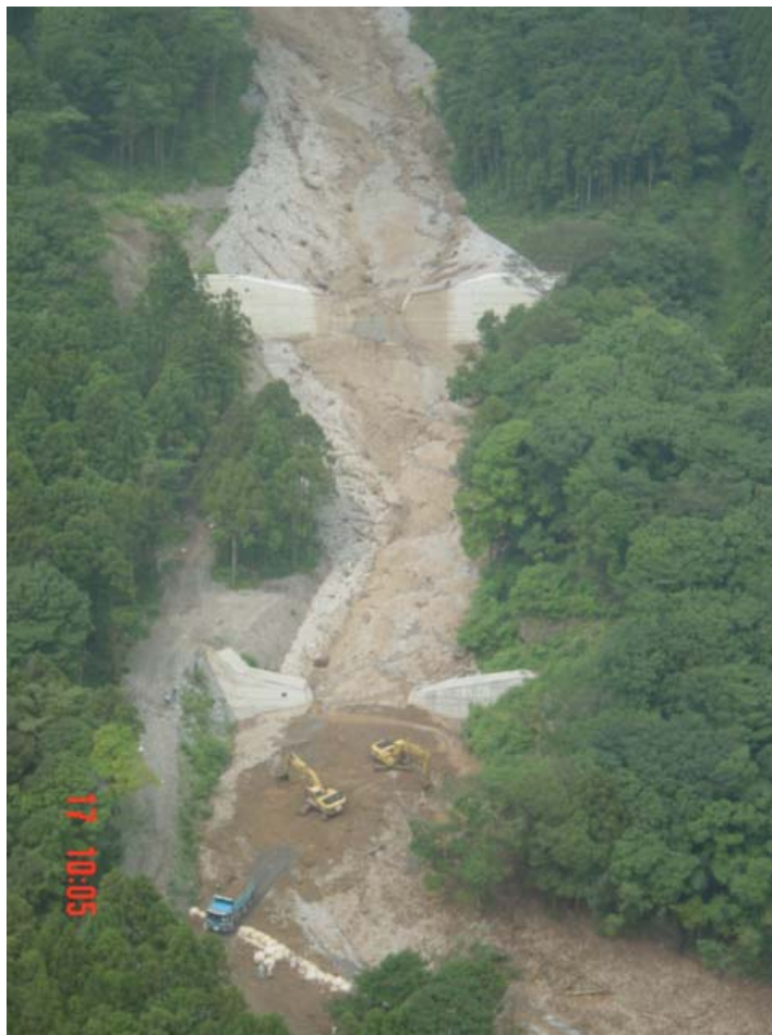
写真－3 西之貝戸川での土石流の捕捉状況（2002年7月17日撮影）
