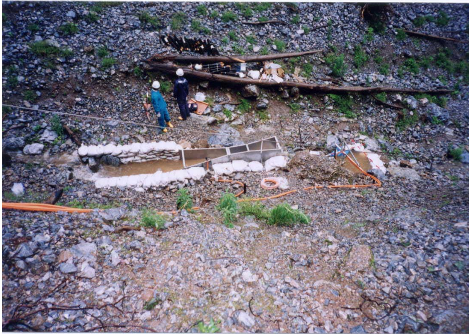
写真－4 濁度計の全景（2003年6月24日撮影）
