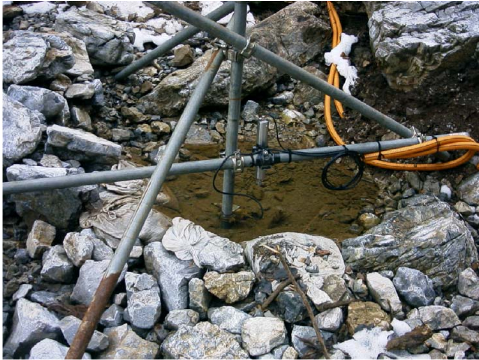
写真－6 濁度計の再設置状況（2004年2月12日撮影）
