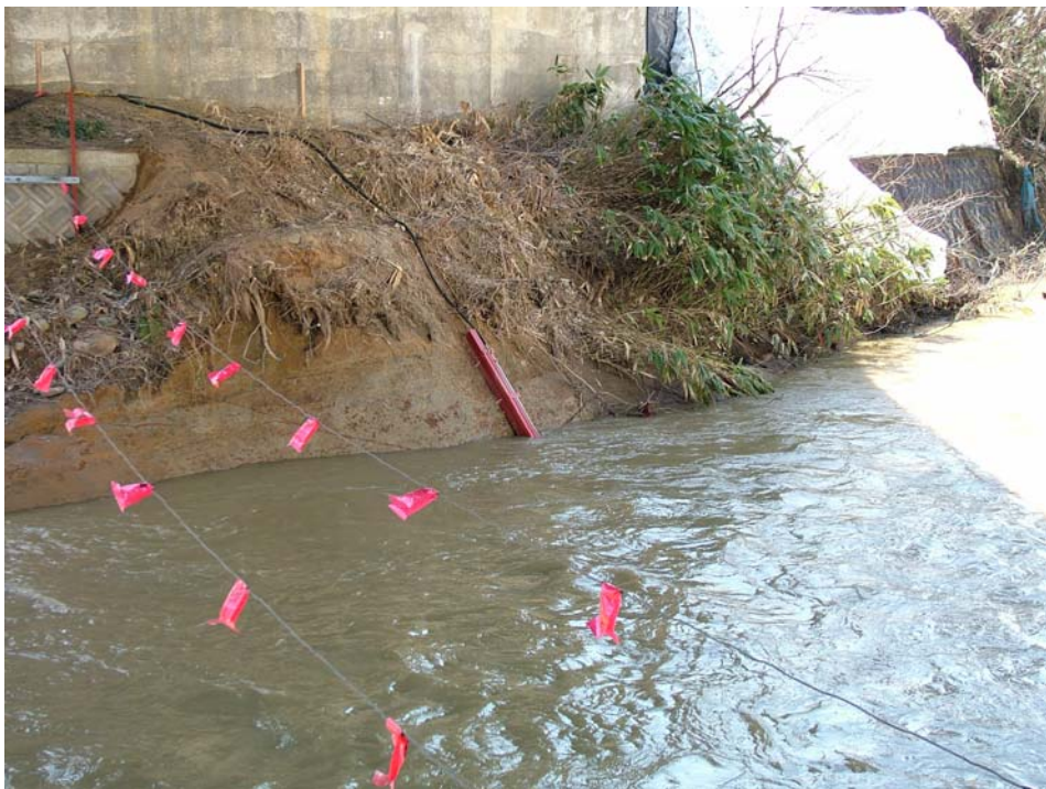
写真－9 濁度計設置箇所の様子
