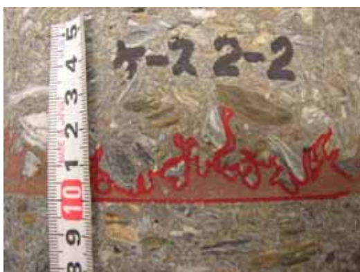
写真 7.1 打継処理部(ケース 2-2) ( )
