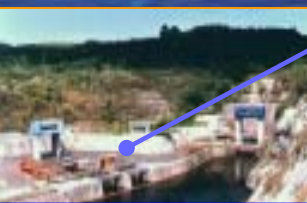
T. Agung Tunnel (91)
