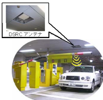
図 3.4-3 ETC 車載器による駐車場入退出管理（センチュリー豊田ビル）
