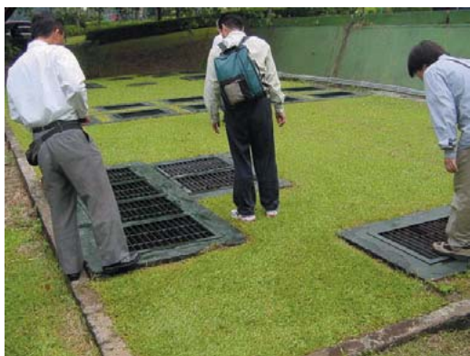
処理施設上部
