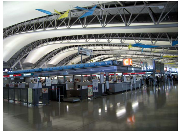
写真-18 内部構造/内部空間の洗練(関西国際空港. 1994)
