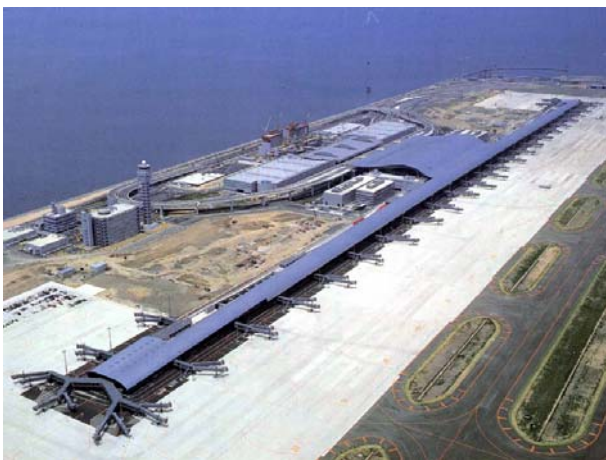
写真-16 関西国際空港 96) (1994)
