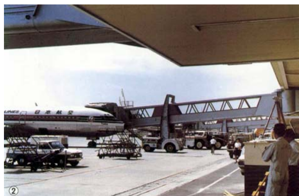
写真-7 国内初のボーディングブリッジ(福岡空港. 1969) 97)
