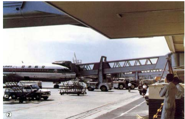
写真-7 国内初のボーディングブリッジ(福岡空港. 1969) 97)
