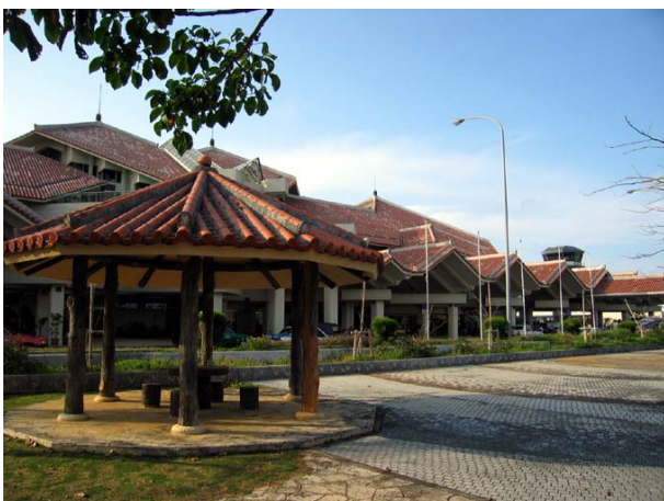
写真-17 地域性を取り入れた建築意匠(宮古空港. 1997)
