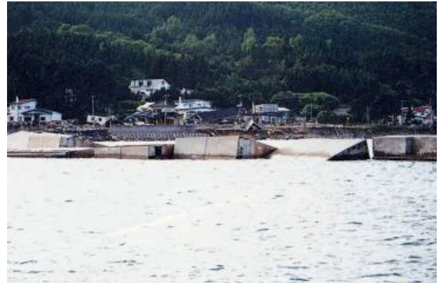
写真-12 奥尻港北防波堤ケーソンの滑動・転倒 (北海道南西沖地震)
