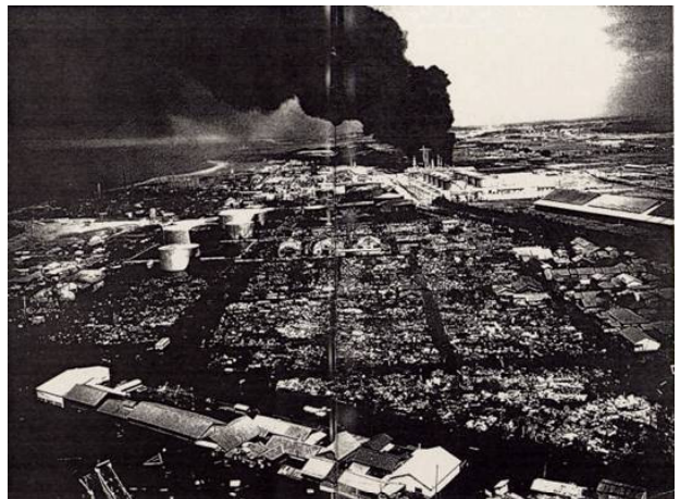
写真-17 新潟地震における石油タンク火災
