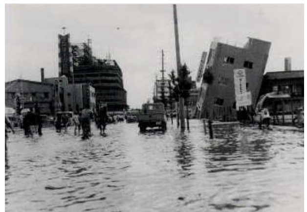
写真-13 地震直後60cm程度浸水した新潟市の 明石通り（新潟地震）
