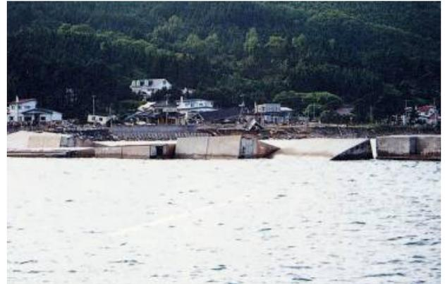
写真-12 奥尻港北防波堤ケーソンの滑動・転倒
