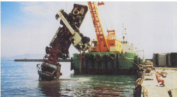
写真-6 奥尻港内へ転落した車両の引き上げ作業
