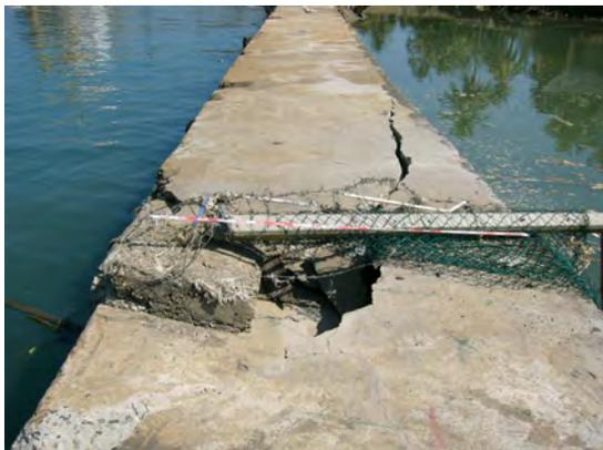
写真-3.11 破損・吸い出しの顕著な箇所
