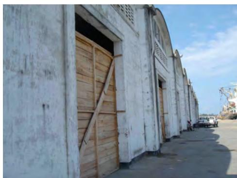
写真-3.6 破損した扉が修復されている公共上屋
