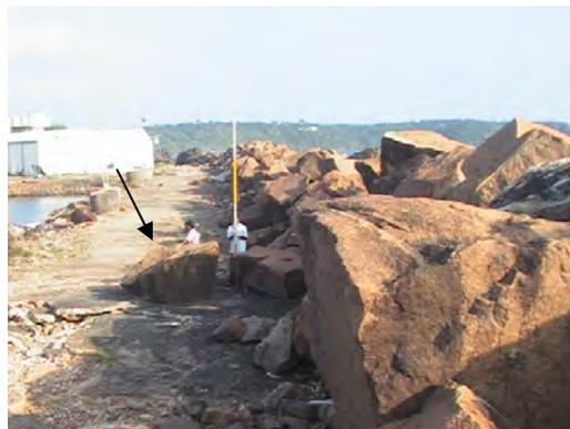
写真-3.15 被災直後の主防波堤の状況及び岩石の崩落状況（矢印）（左：港内側，右：港外側，撮影・日本港湾コンサルタント）
