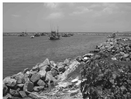
写真-3.5 石積みの護岸 ※広瀬が撮影
