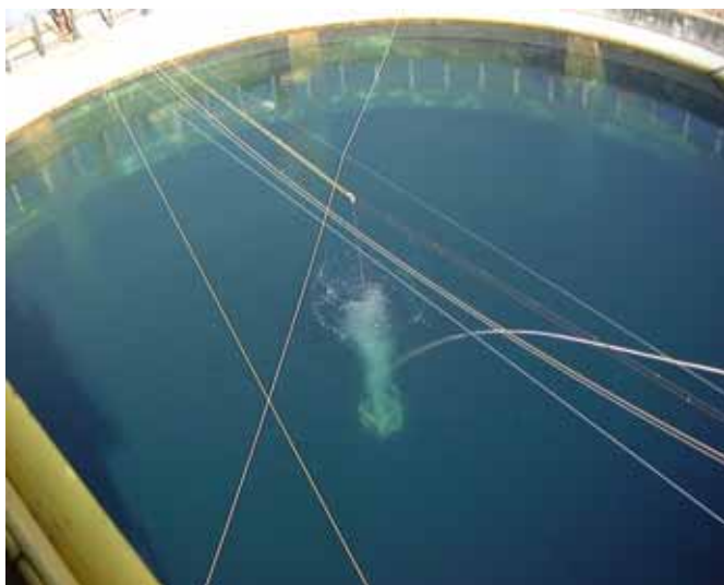
散気装置設置水深 5m
