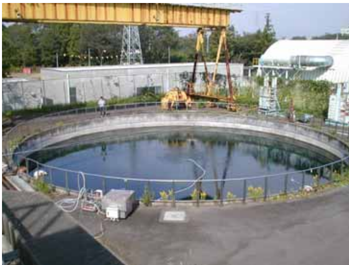
写真 10 装置設置状況
