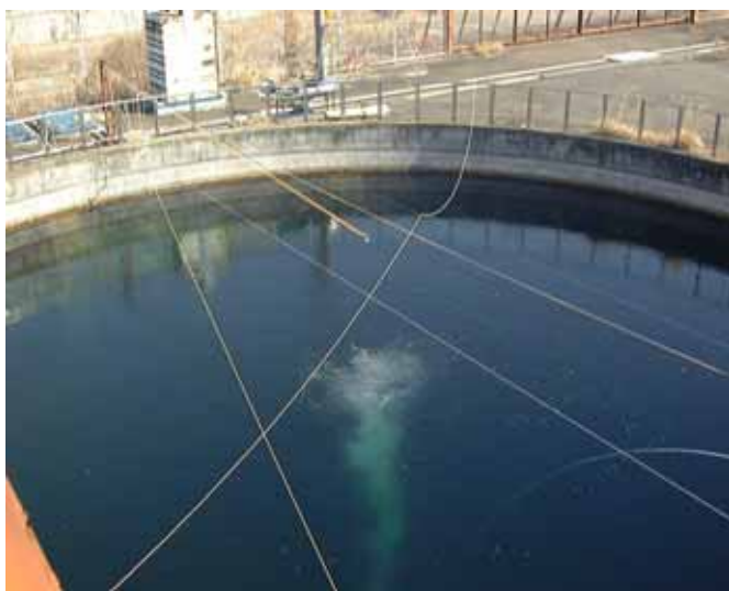
散気装置設置水深 10m
