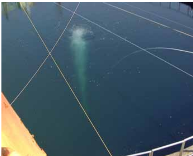
散気装置設置水深 18m
