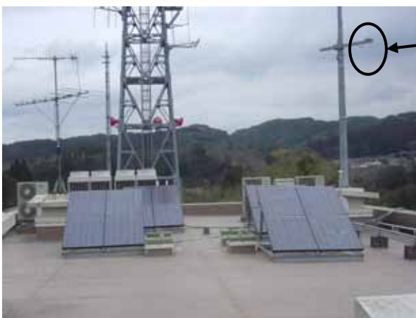
写真 18 亀山ダム管理事務所 日射計
