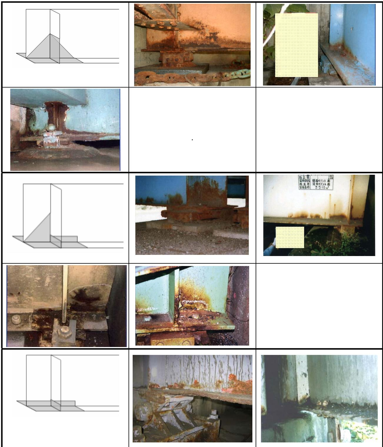
図-3.11(1) 腐食事例（桁端部全体）
