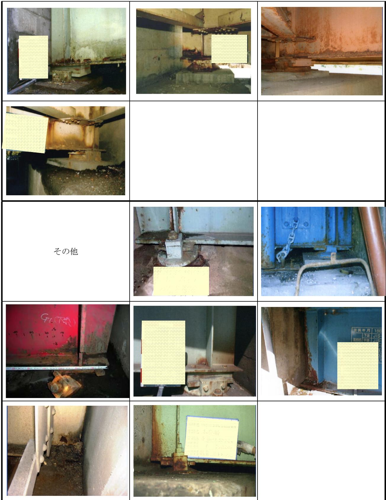
図-3.11(2) 腐食事例（桁端部全体）
