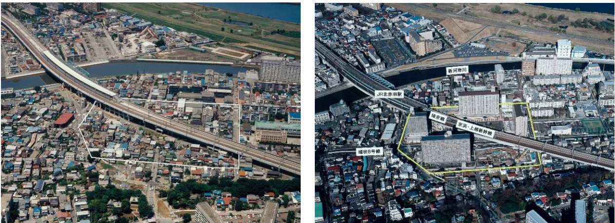
図 7-1 整備前後の北赤羽地区（左：整備前／右：整備後）
