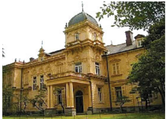
写真 5-6 旧岩崎邸庭園「洋館」 写真提供：東京都建設局
