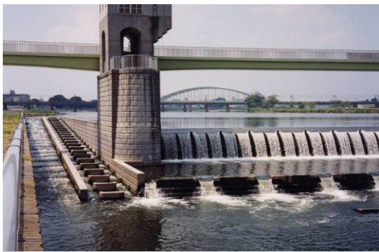
写真 5-3 右岸アイスハーバーと緩勾配水路式魚道 出典：国土交通省関東地方整備局
